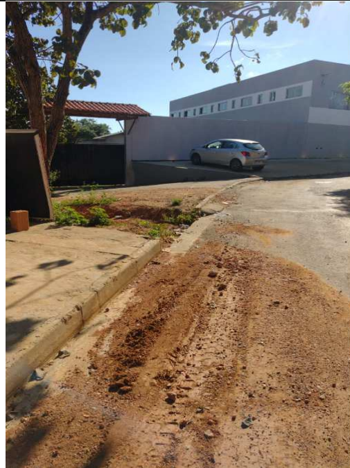
Drenagem da rua Santa Cruz
